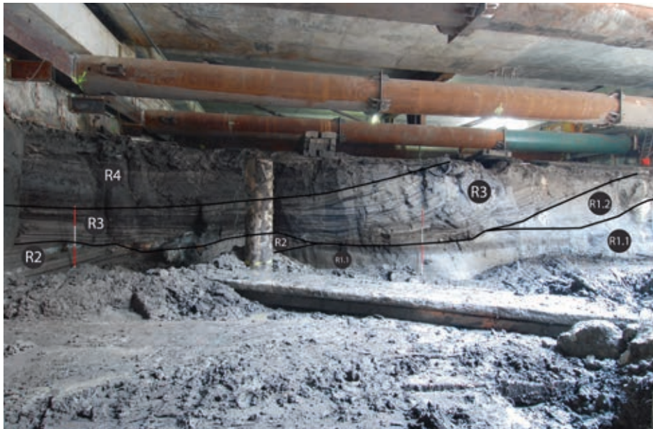
2 Profiel (noord) met de verschillende stroomgeulen in de Amstelbedding op het Rokin tussen circa zes en elf meter beneden NAP (zie voor
