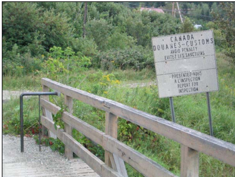
Photo 11 : Le pont international, construit par erreur en 1906, depuis le côté américain, à Estcourt
